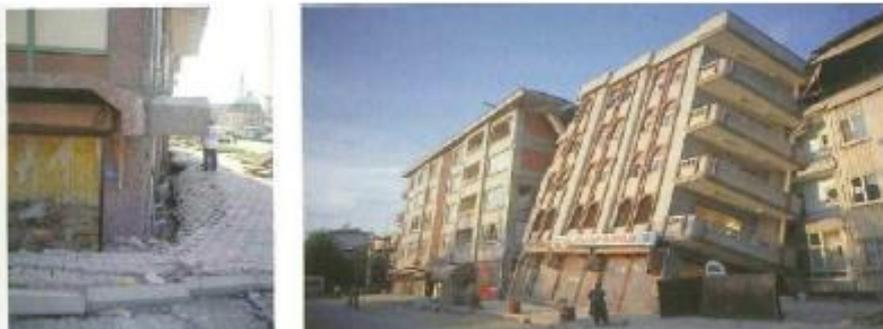
Figura 4.17: Recalque por liquefação do solo;
