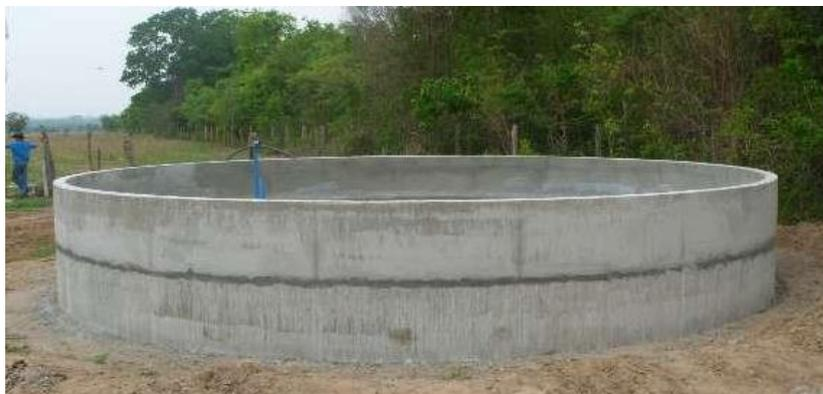
Figura 3.1: Reservatório parcialmente enterrado.
