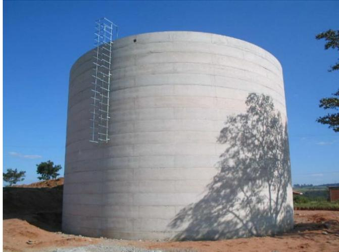
Figura 3.2: Reservatório simplesmente apoiado.
