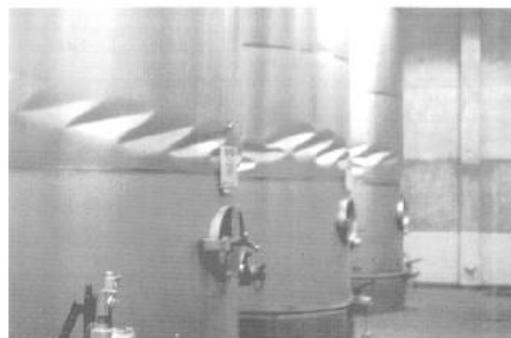
Figura 4.19: Deformação do reservatório do tipo diamante;
