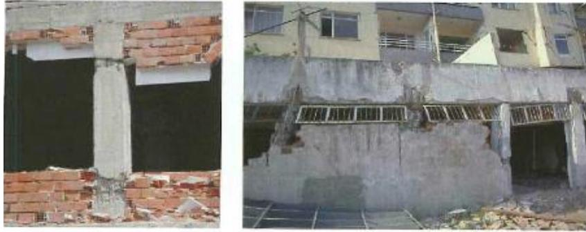
Figura 4.15: Pilares com deformações impedidas;
