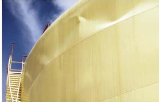
Figura 4.20: Danos na cobertura devido à sucção;
