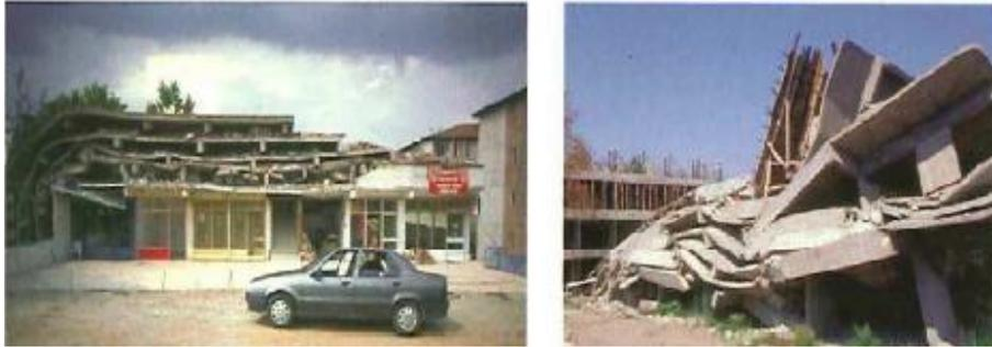
Figura 4.12: Colapso em bloco
