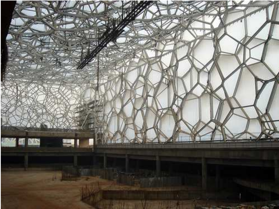
Figura 1.5– Centro olímpico de natação em Beijing, China (durante a construção).
