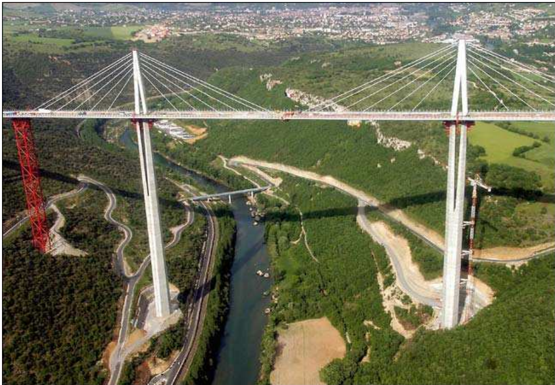
Figura 1.2 – Viaduto de Millau na França (vista aérea).
