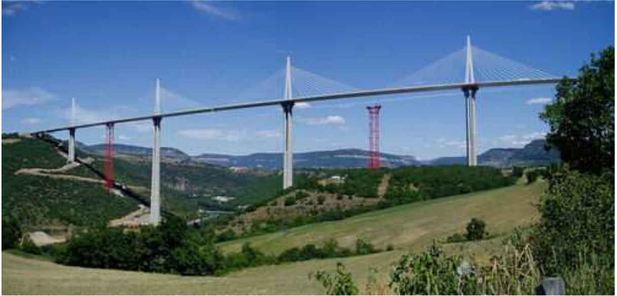
Figura 1.3 – Viaduto de Millau na França.
