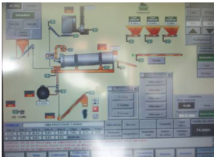
FIGURA 6.6: Painel de controle da usina de asfalto.
