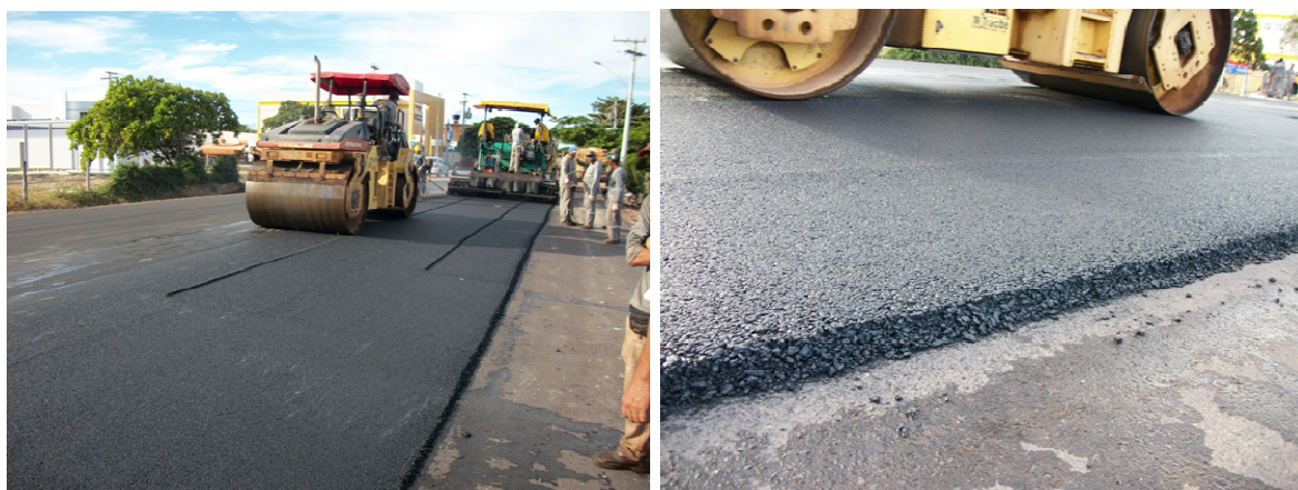
FIGURA 6.10: Compactação do SMA.
