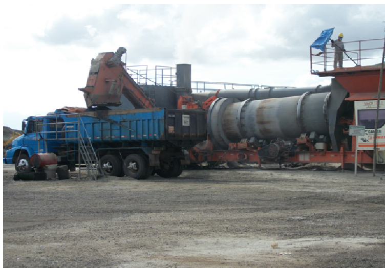
FIGURA 6.5: Aspectos da usina de asfalto em funcionamento.
