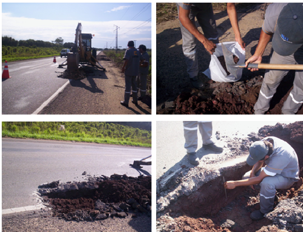
FIGURA 6.3: Abertura de poços de sondagem.
