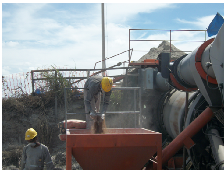
FIGURA 6.7: Adição manual do bagaço de cana ao silo de fíler.
