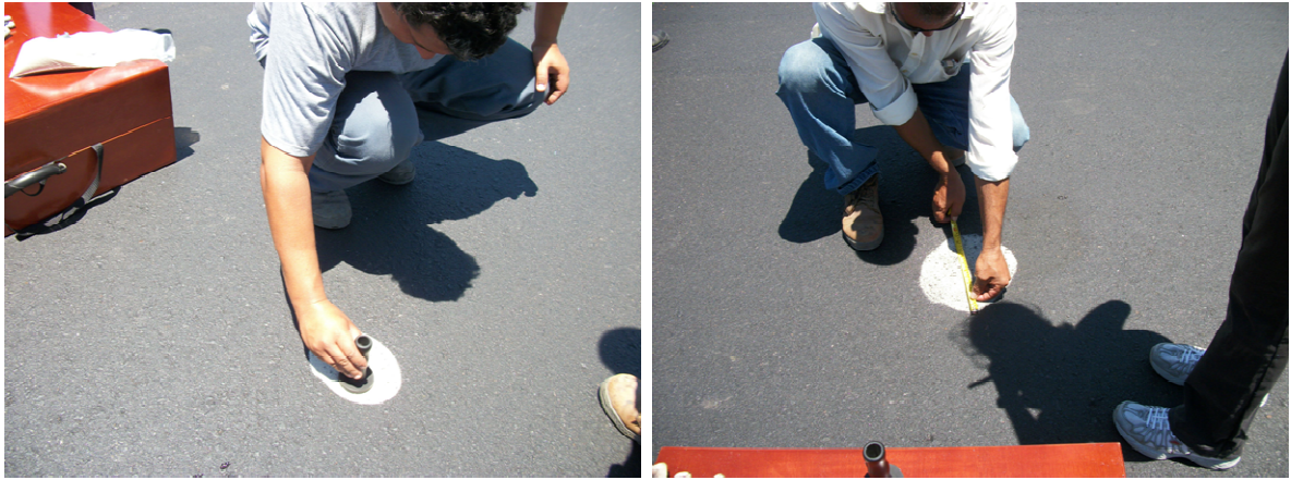
FIGURA 3.30: Ensaio de mancha de areia.
