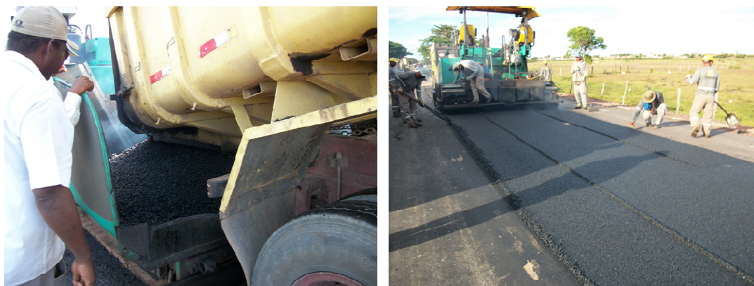
FIGURA 6.9: Aplicação da mistura SMA na BR 356.
