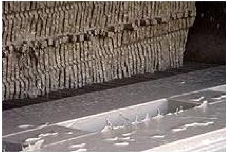
Figura 3.13: Poço de recolhimento da polpa abrasiva
