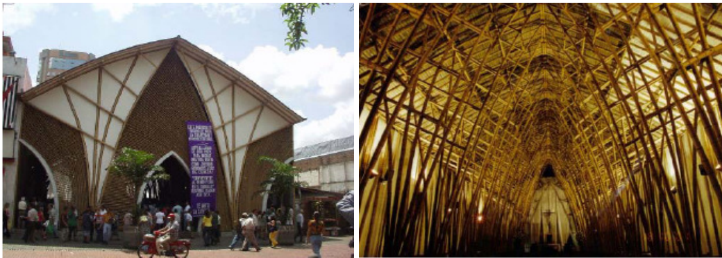
Figura 2.7: Vistas frontal e interna da Catedral construída em bambu na Colômbia. GHAVAMI (arquivo pessoal).
