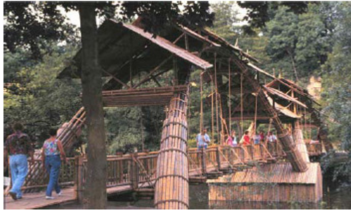
Figura 2.6: Ponte de bambu em Stuttgart, Alemanha. GHAVAMI (arquivo pessoal).
