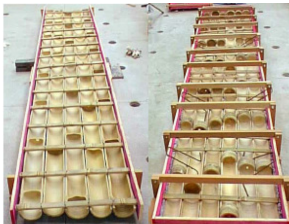
Figura 2.2: Formas permanentes de lajes armadas com bambu. ACHÁ (2002).
