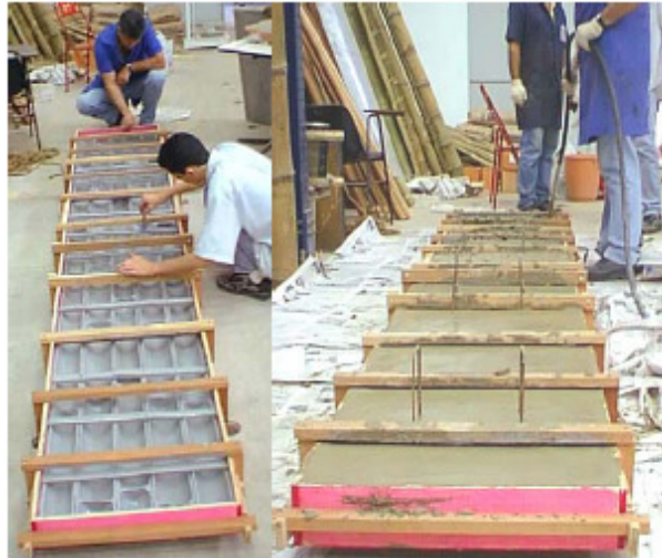
Figura 2.3: Tratamento e concretagem de lajes armadas com bambu. ACHÁ (2002).
