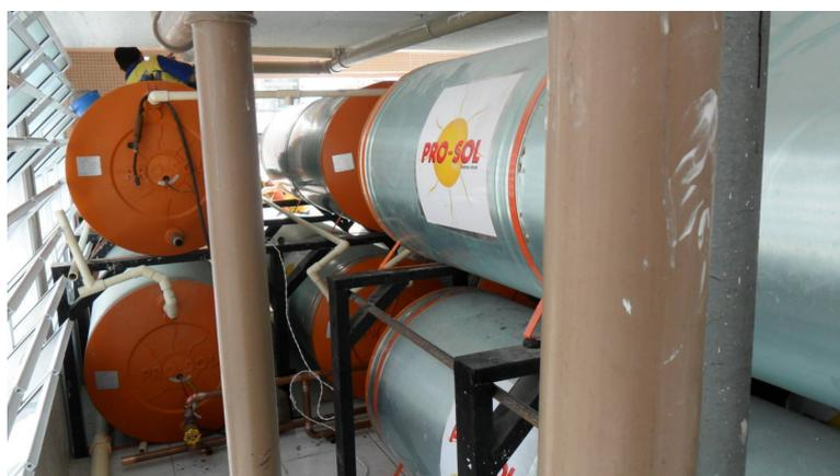
Figura 31: Sistema de aquecimento solar, Construtora A.
