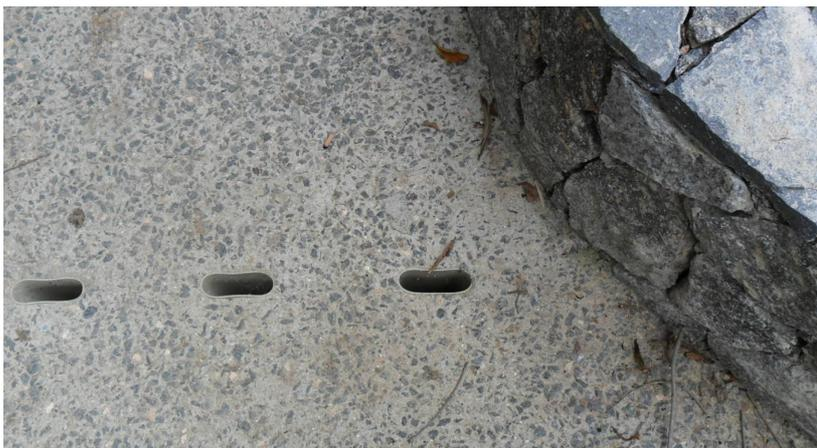
Figura 62: Captação de águas pluviais, Construtora E.
