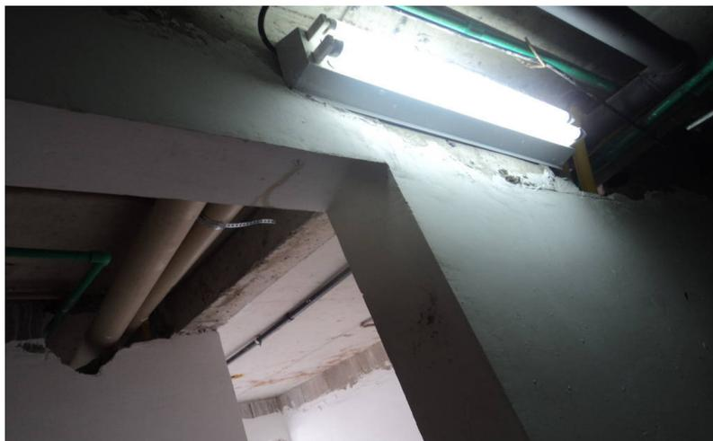
Figura 43: Lâmpadas de baixo consumo, Construtora C.
