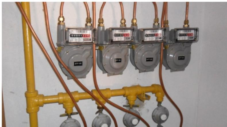
Figura 58: Medição individualizada de gás, Construtora D.
