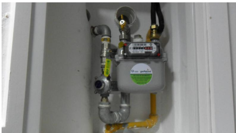
Figura 37: Medidor de gás, Construtora B.
