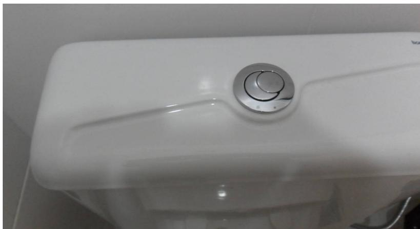
Figura 28: Dispositivo economizador de água, Construtora A.
