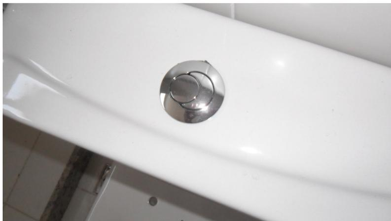
Figura 55: Sistema economizador de água, Construtora D.
