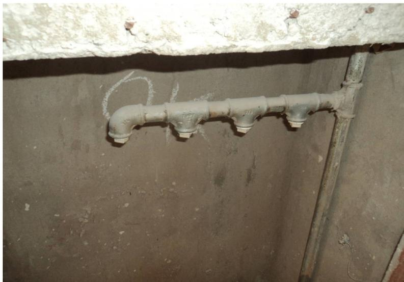
Figura 45: Sistema individualizado de gás, Construtora C.
