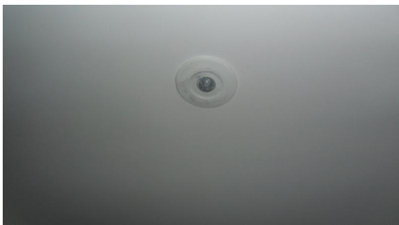
Figura 57: Dispositivo economizador de área comum, Construtora D.
