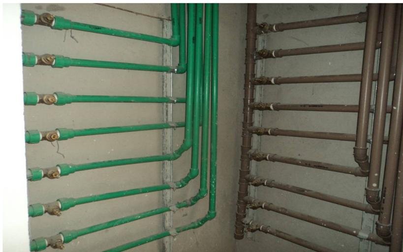
Figura 40: Sistema de medição individualizada de água, Construtora C.
