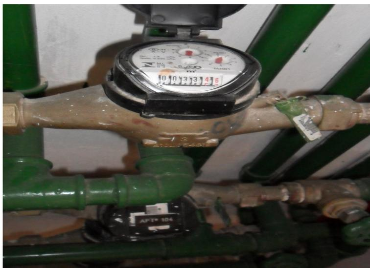
Figura 54: Medição individualizada de água, Construtora D.
