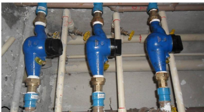
Figura 27: Sistema individualizado de água, Construtora A.
