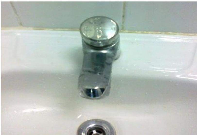
Figura 69: Torneira com dispositivo economizador de água, Construtora F.
