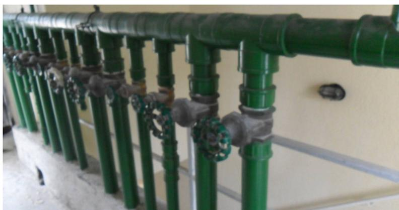
Figura 33: Sistema de medição individualizada de água, Construtora B.
