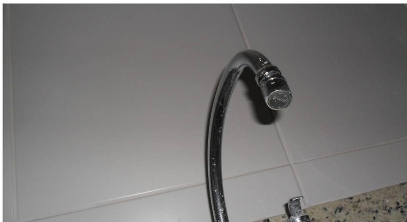
Figura 34: Dispositivo economizador de água, Construtora B.
