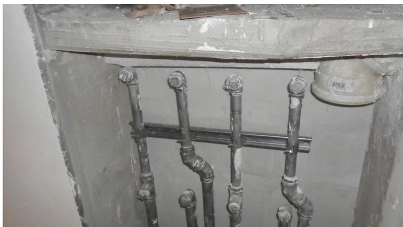
Figura 32: Medição individualizada de gás, Construtora A.
