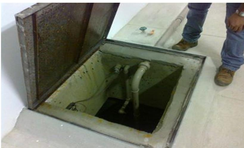
Figura 68: Poço para armazenamento de águas pluviais, Construtora F.
