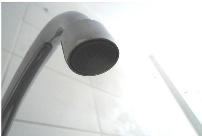
Figura 41: Dispositivo economizador de água, Construtora C.
