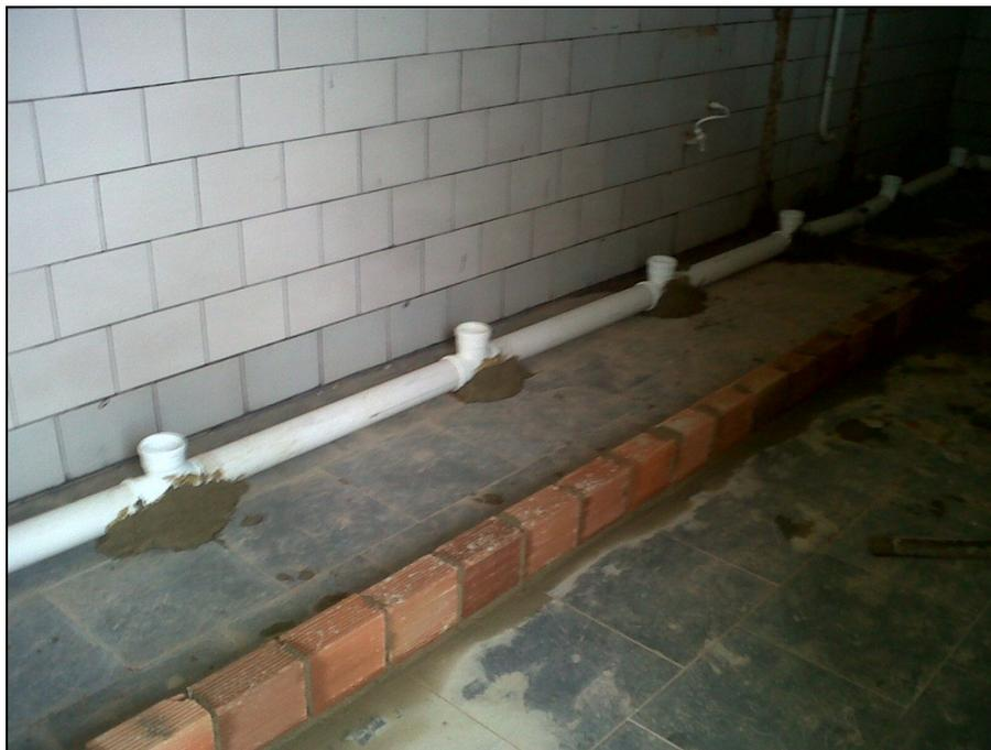
Figura 12: Adaptação do vestiário do estádio para instalação de vasos sanitários
