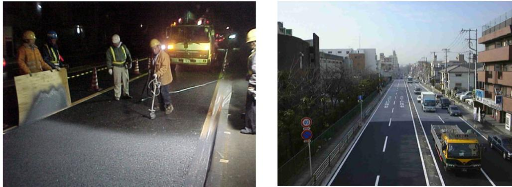
Figura 23: Usando o nano material  $\text{TiO}_2$  fotocatalítico em capeamento de pista, para a redução da poluição: a esquerda mostra a aplicação do revestimento e a direita a estrada pronta, mostrando uma cor mais clara.
