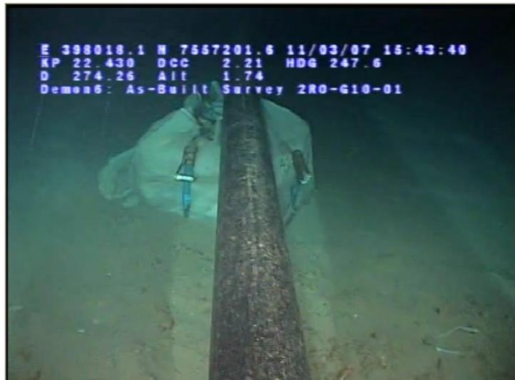
Figura 2.9: Vão livre corrigido com Grout Bag.
