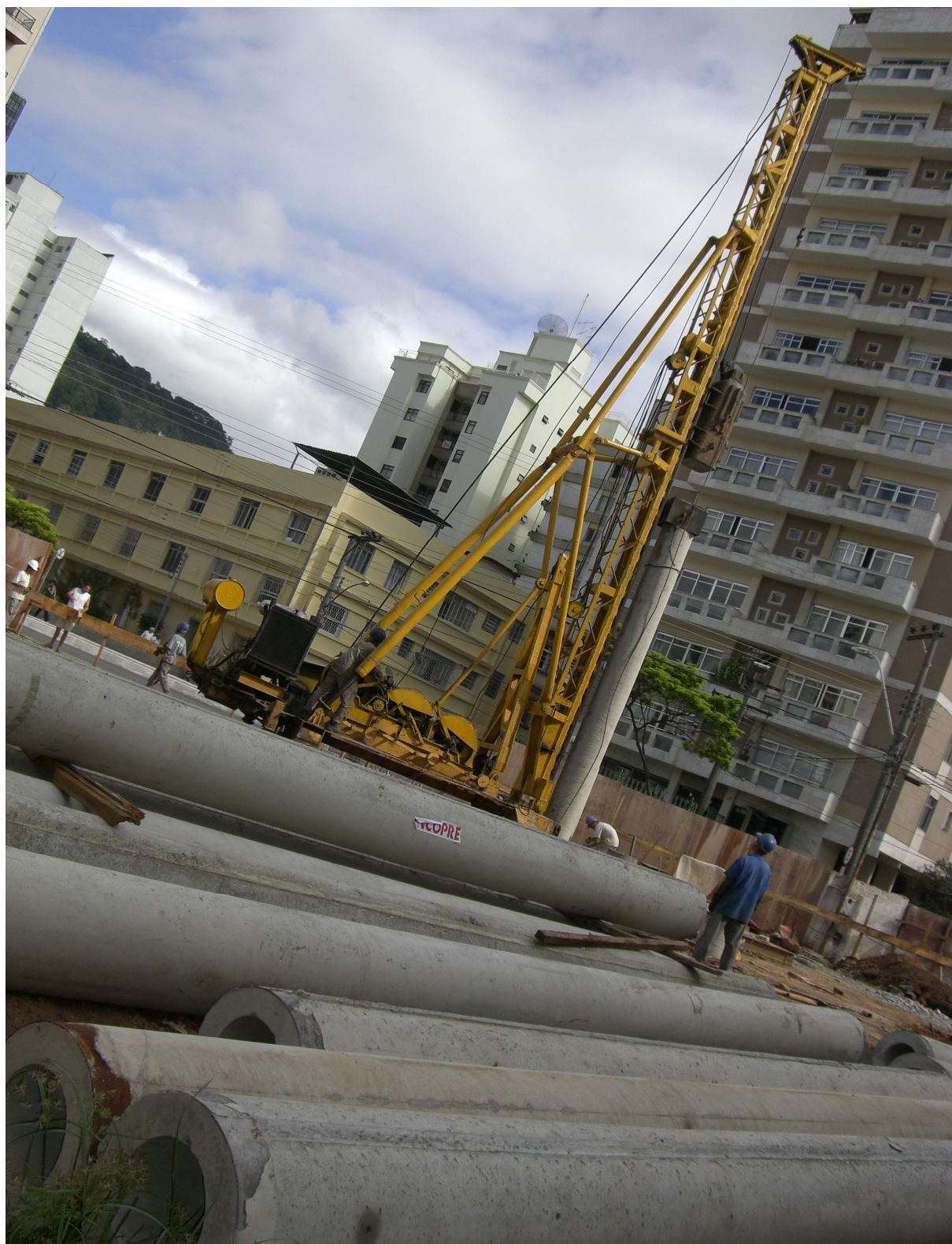
Canteiro de obra
