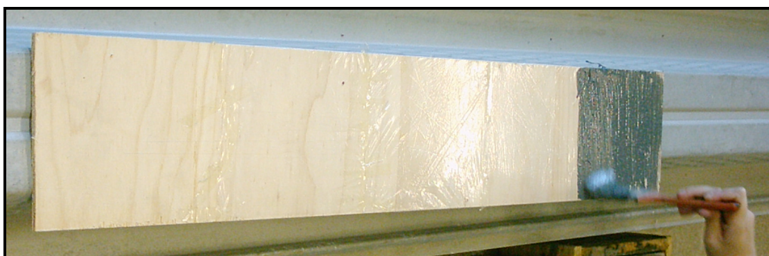
Figura 3.22 – Aplicação de sistema de impermeabilização sobre plástico
