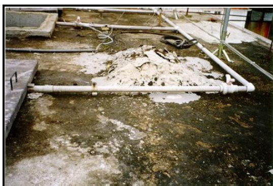
Figura 2.6 – Obstáculos para a impermeabilização – MORAES (2002).
