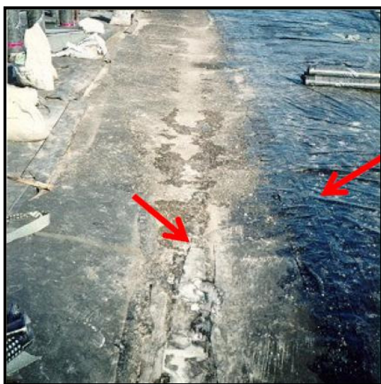
Figura 2.3 – Problema de transpasse em manta asfáltica – MORAES (2002).
