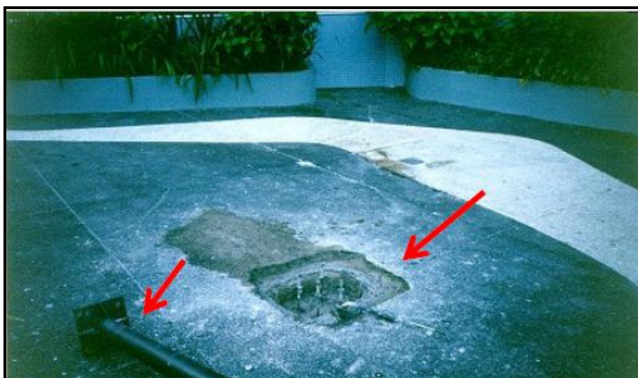
Figura 2.7 – Fixação de luminária após a execução da impermeabilização – MORAES (2002).
