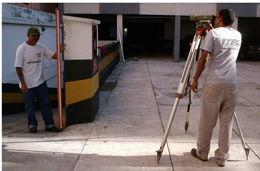
Figura 2.7 – Medida de recalques por meio de nivelamento geométrico.
