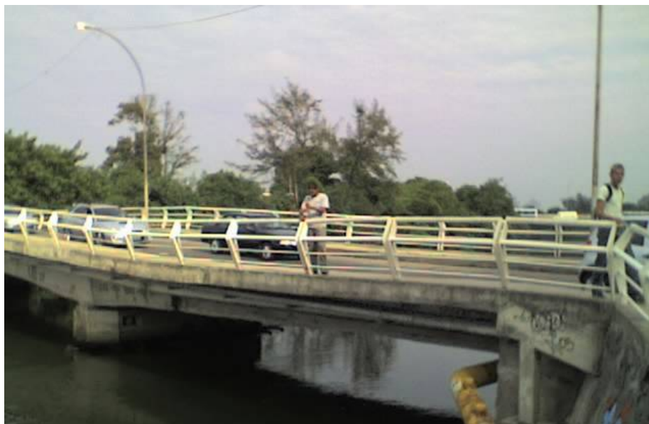
Figura 3.6 – Ponte velha da Barra da Tijuca: vista parcial (2007).
