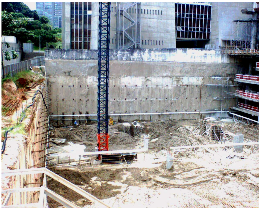
Figura 3.18 – Construção de cortinas adjacentes ao conjunto arquitetônico existente.
