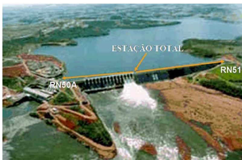
Figura 2.21 – Barragem de Salto Caxias (adaptada de GOMES, 2006).
