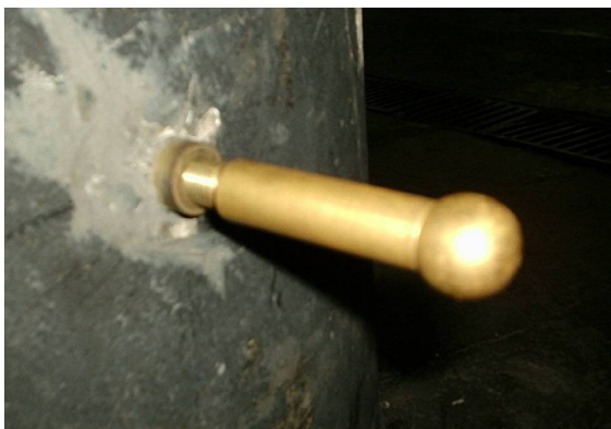
Figura 2.11 – Pino macho sendo rosqueado na fêmea fixa no elemento estrutural.
