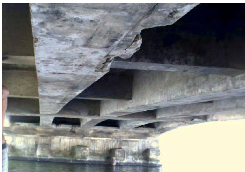
Figura 3.3 – Ponte velha da Barra da Tijuca: vista inferior (2003).
