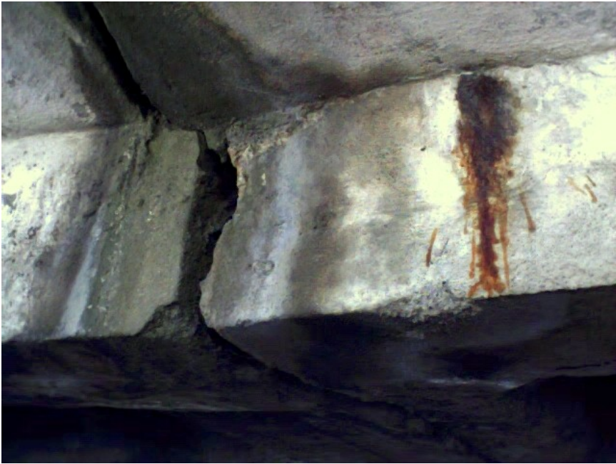
Figura 3.4 – Ponte velha da Barra da Tijuca: detalhe do dente Gerber (2003).
