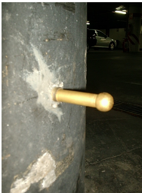
Figura 3.23 – Pino fixado em pilar.
