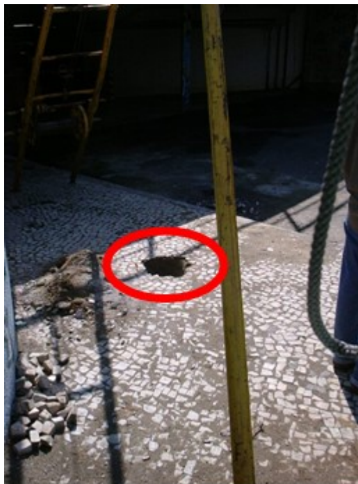
Figura 3.21 – Instalação do Benchmark .
