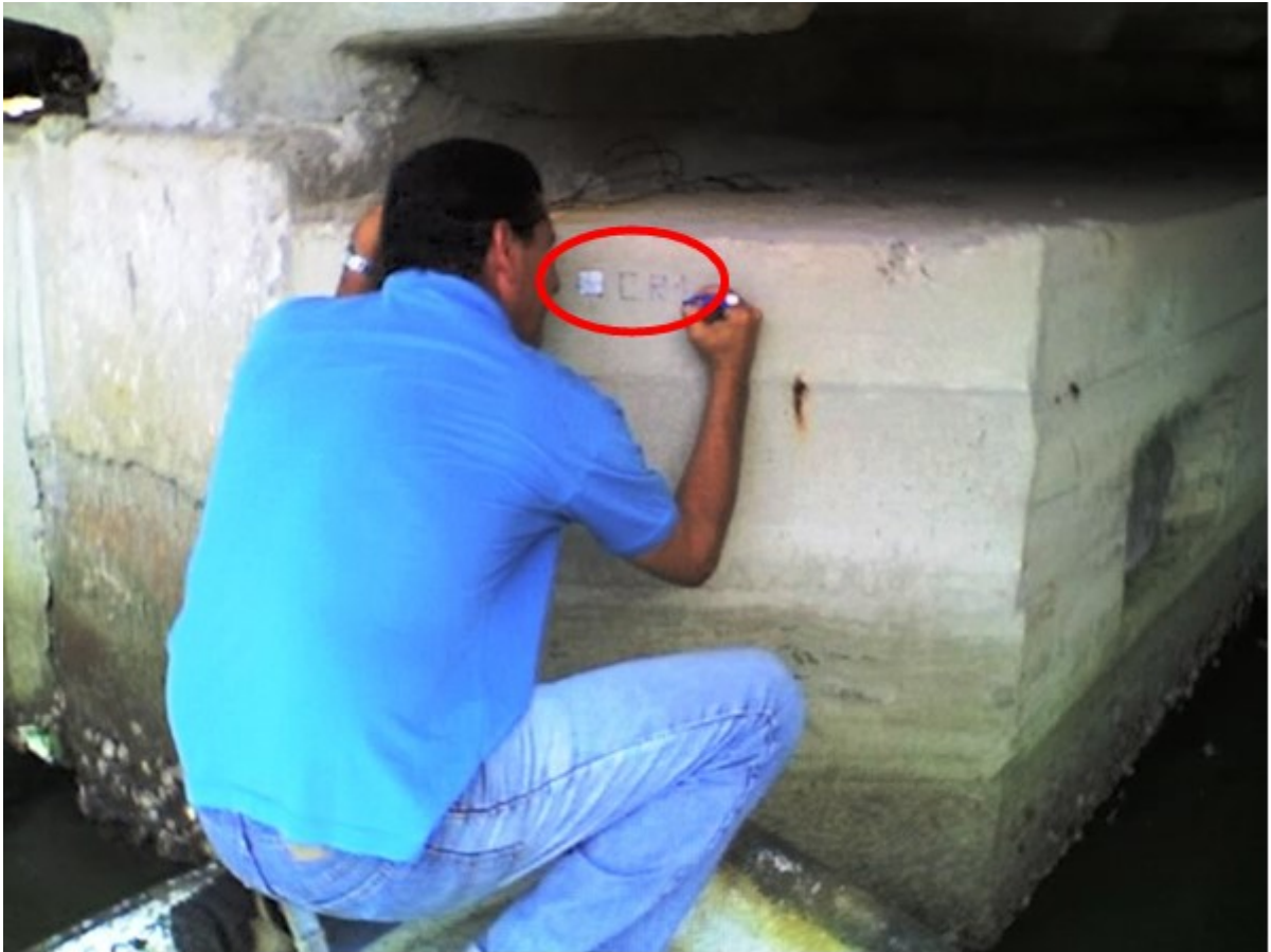
Figura 3.8 – Instalação e identificação do alvo CR1.
