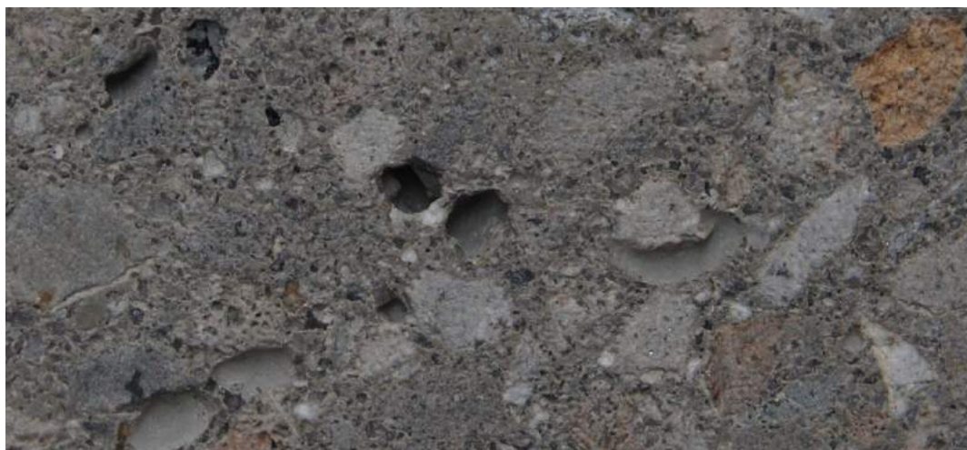
Figura 5.20 – Superfície a ser colada com rugosidade do elemento C50-30-03.
