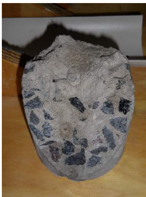
Figura 5.6 – Elemento estrutural disgregado em função do jateamento de água.
