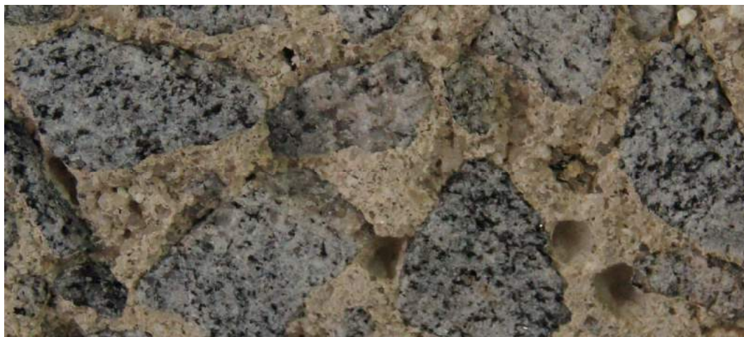
Figura 5.18 – Superfície a ser colada com rugosidade do elemento C20-60-01.
