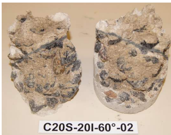
Figura 5.25 – C20S-20I-60-02 verificação da junta de colagem após a ruptura.
