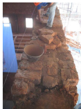
Foto 7.26 – Nivelamento das paredes do altar-mor
