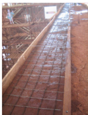
Foto 7.27 - Molde para o concretagem do suporte dos frechais
