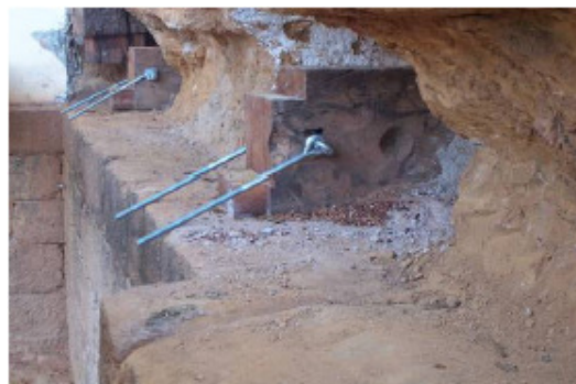
Foto 7.13 - Colocação da nova trave; travamento no nível da baldrame.
