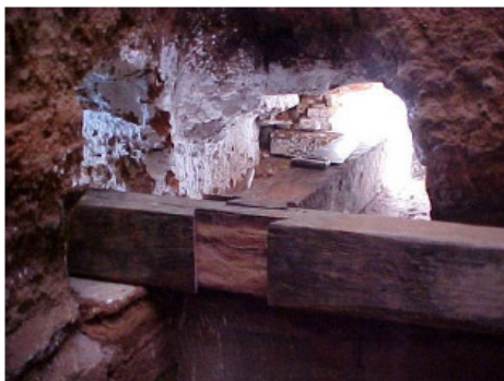
Foto 7.12 - Novas traves para a consolidação das torres
