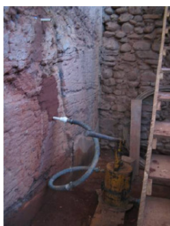
Foto 7.17 - Injeção das fissuras na taipa
