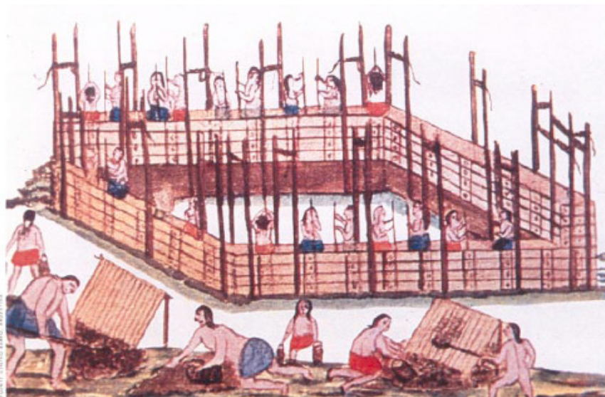
Figura 4.2 - Modo de levantar paredes de terra apisoadas
