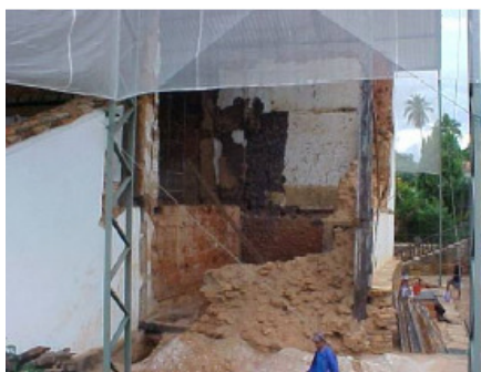
Foto 7.16 - Desmonte das paredes do camarim
