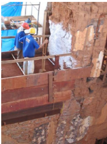
Foto 7.23 - Repara-se o uso de cal (macha branca)
