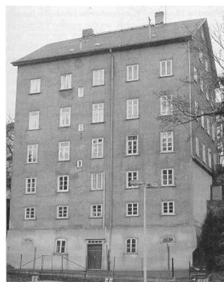
Foto 4.13 - Prédio de taipa de pilão: Hainallee 1, Weilburg, Alemanha, 1828
