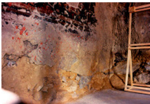
Foto 5.5 - Eflorescência em uma parede com murais na Índia
