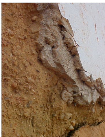
Foto 7.10 - Revestimento com arame de ferro (da intervenção de 1996-'99).
