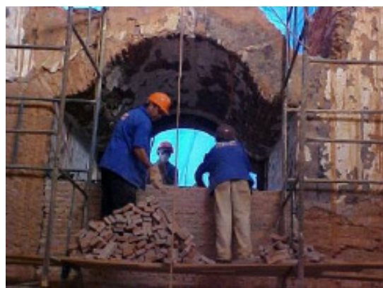
Foto 7.20 - Alvenaria de tijolo está sendo retirada
