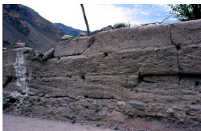
Foto 4.7 - Paredes de taipa de pilão com alicerces de pedra, Spiti, Índia
