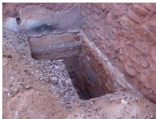
Foto 7.3 - Prospeção no “camarim” mostra o alicerce de “formigão”
