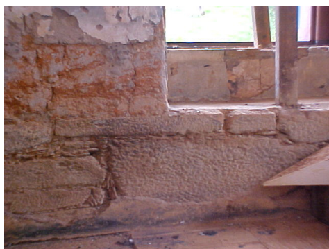
Foto 7.4 – Baldrame da sacristia
