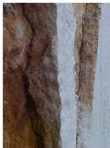
Foto 7.11 - Revestimento do consistório, considerado original.
