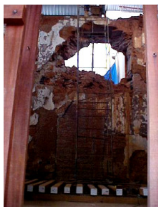
Foto 7.19 - Cama de madeira abaixo da taipa que seja desmontado
