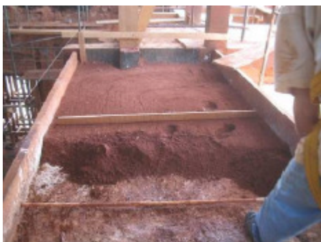
Foto 7.25 - Nivelamento das paredes da nave
