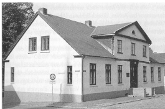
Foto 4.12 - Casa de taipa de pilão, Norderstr. 1, Meldorf, Alemanha, 1795
