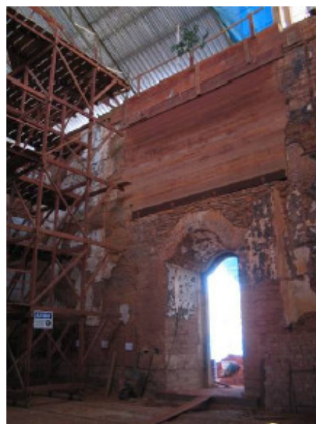
Foto 7.24 - Estado final da reconstituição da taipa acima do porta lateral direita
