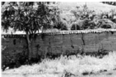
Foto 5.4 - Antigo muro de taipa de pilão na região de Lagoa Dourada- MG
