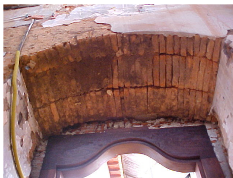
Foto 7.6 - Porta exterior da sacristia: um arco abaulado
