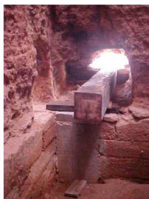
Foto 7.14 - Uma nova taipa para apoiar nova baldrame
