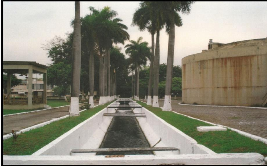
**Figura 12:** Canal na ETE Penha conduz o efluente já tratado ao corpo receptor
