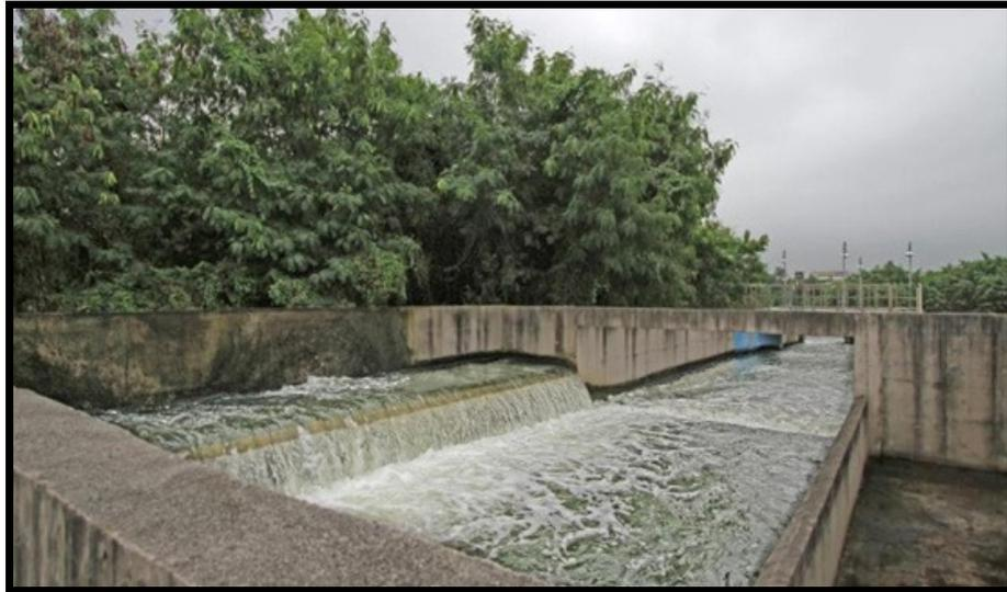
**Figura 6:** Lançamento do efluente tratado na ETE Alegria no Canal do Cunha
