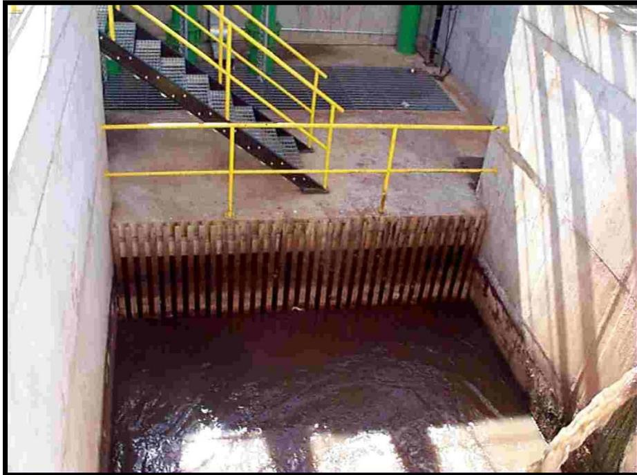
**Figura 4:** Remoção dos sólidos grosseiros pelo gradeamento
