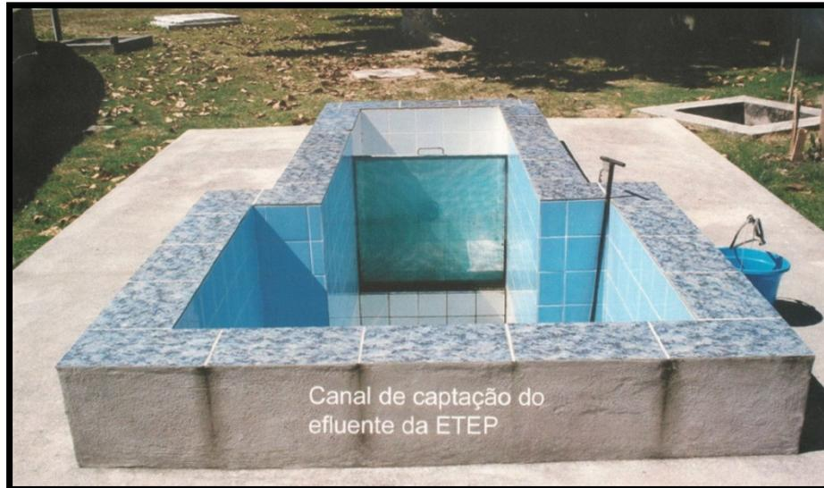
**Figura 13:** Canal de captação do efluente da ETE Penha
