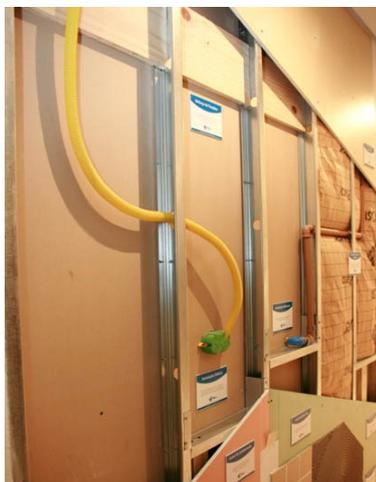
Figura 0.35 – Conduítes para instalações.
