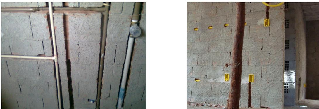
Figura 0.8 – Recortes nos tijolos para instalações.
