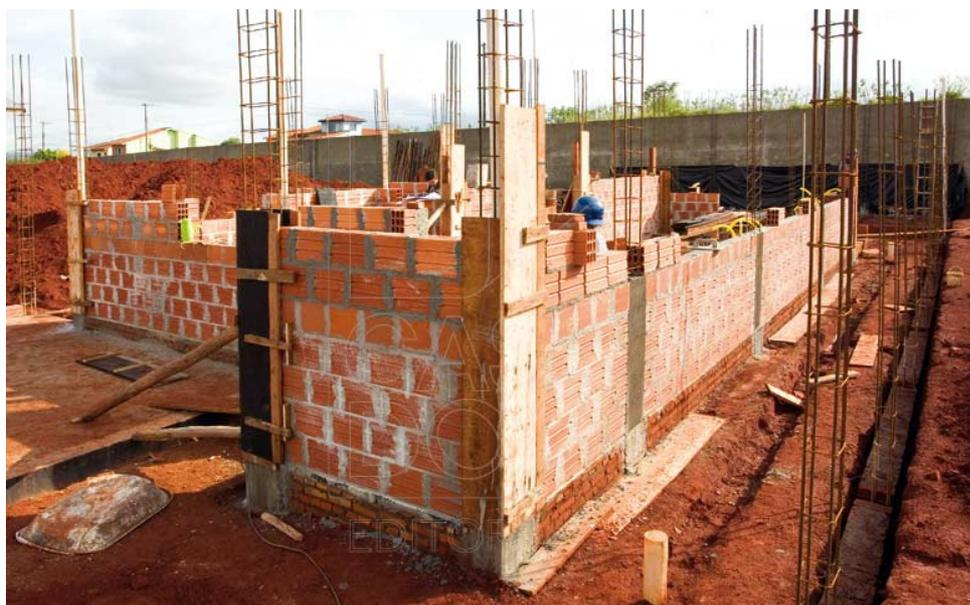
Figura 0.24 – Foto ilustrativa de paredes em alvenaria de vedação.
