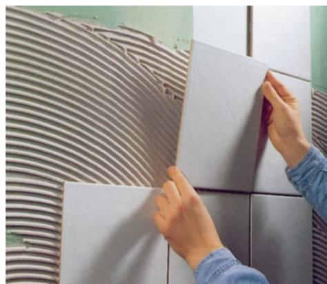
Figura 0.39 – Aplicação de cerâmica
