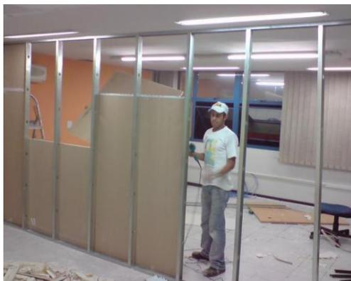
Figura 0.32 – Estrutura para parede de *drywall*
