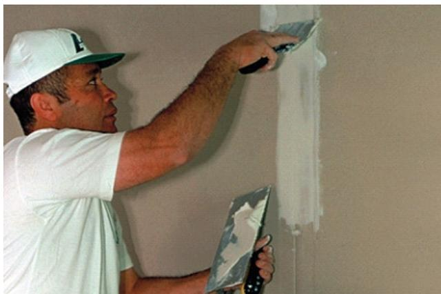
Figura 0.37 – Acabamento nas juntas das placas.
