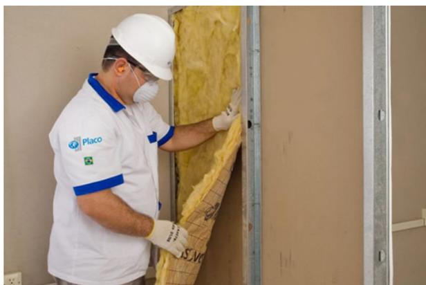
Figura 0.36 – Instalação de lã mineral
