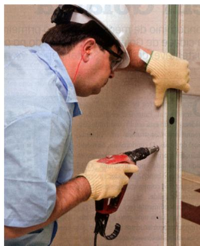
Figura 0.34 – Fixação das placas de gesso acartonado.
