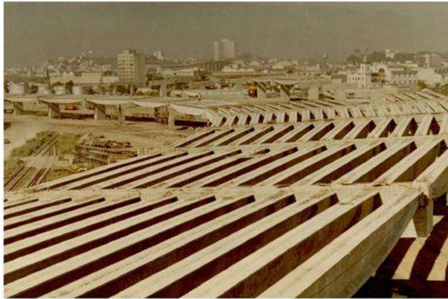
Figura 2.6 – Vista do acesso Rio de Janeiro formado com longarinas pré-moldadas tipo “barriga de peixe”.
