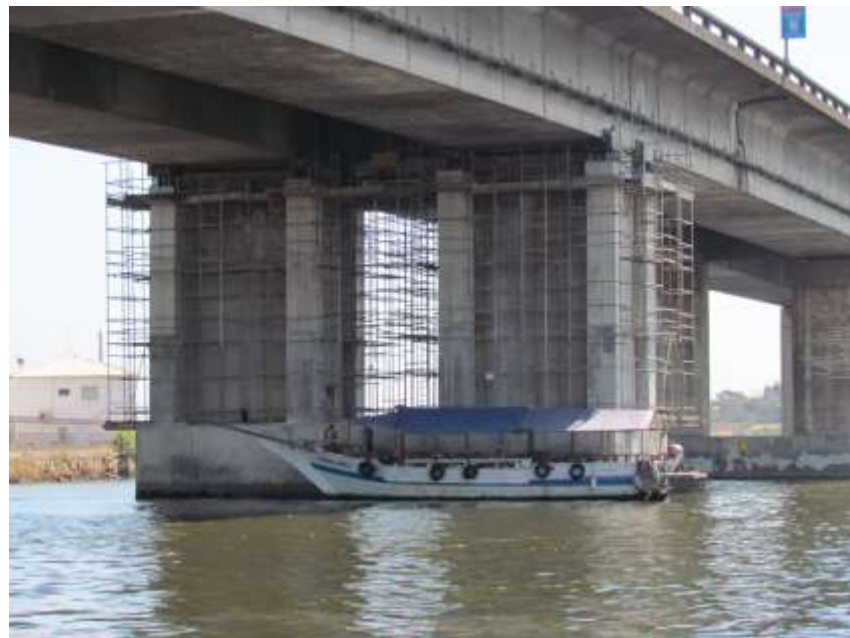
Figura 6.3 – Vista geral da obra de substituição dos aparelhos de apoio do pilar 136 da ponte Rio-Niterói.
