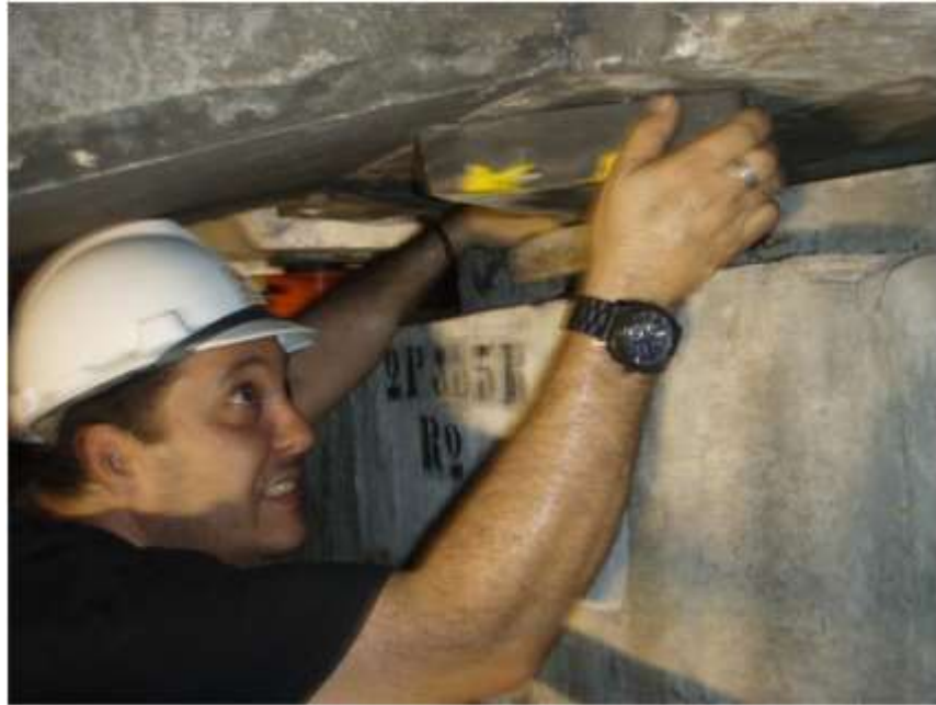
Figura 6.2 – Retirada de aparelho de apoio do pilar 335 rampa R2.
