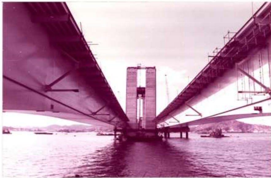
Figura 2.5 - Vista dos caixões metálicos.
