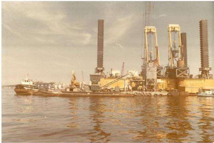
Figura 2.4 – Execução de fundação tipo “Bade-Wirth”.
