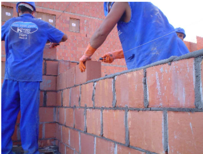
Assentamento da alvenaria estrutural
