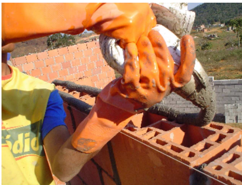
Aplicação de argamassa
