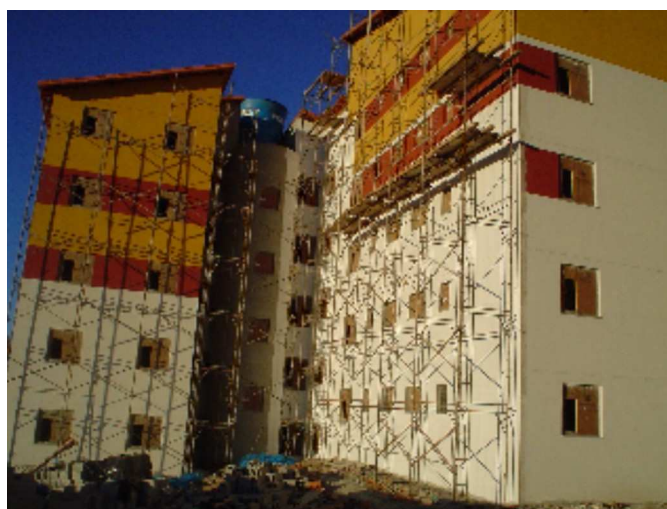
Acabamento Final do Bloco
