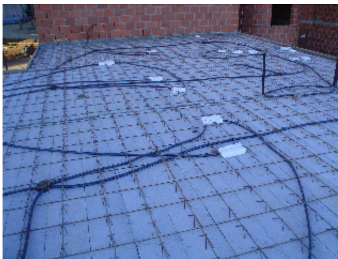
Confecção de painéis das lajes – Laje treliçada
