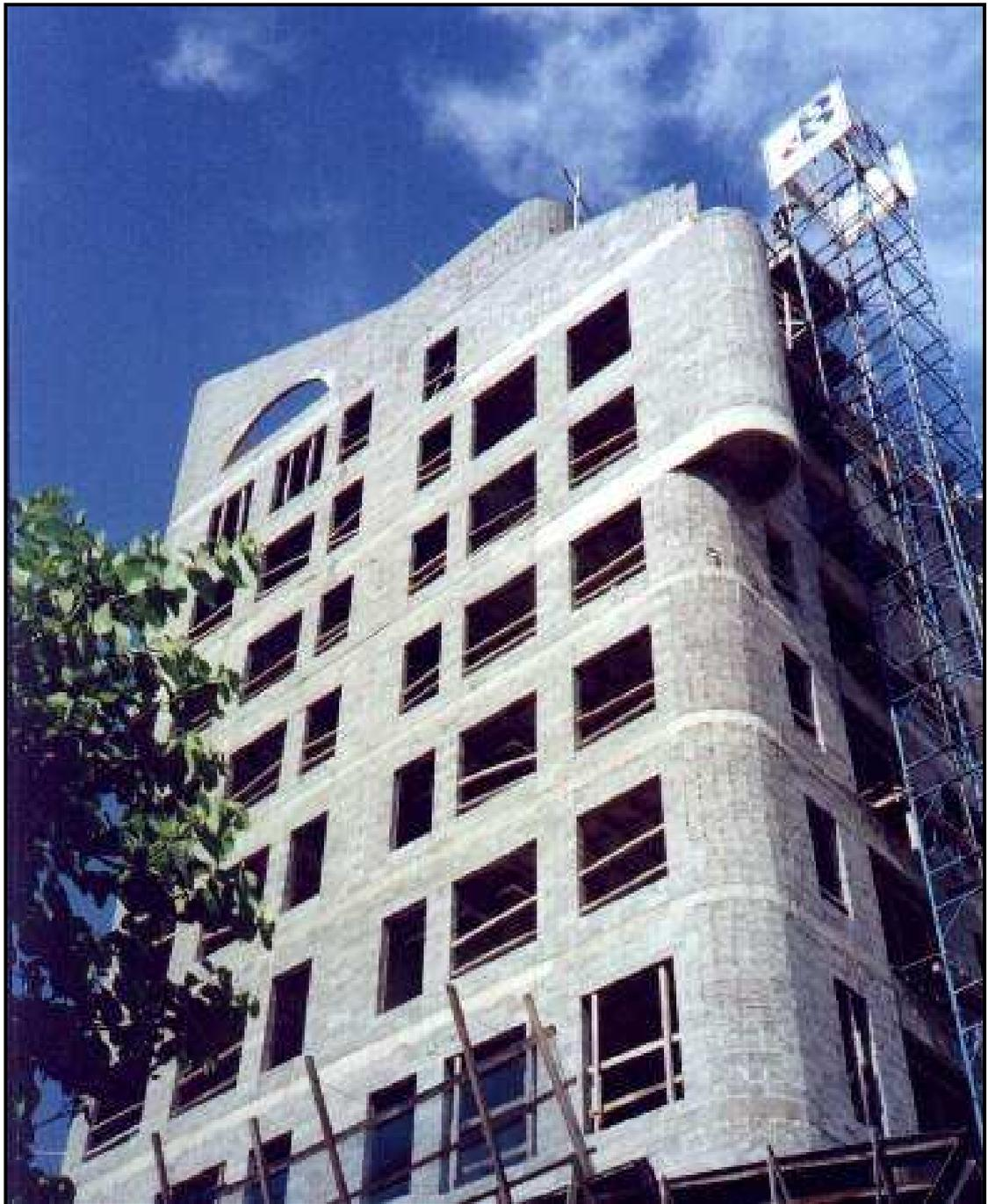
Foto 1.24 – Edificação de padrão médio-alto em alvenaria estrutural, São Paulo.
