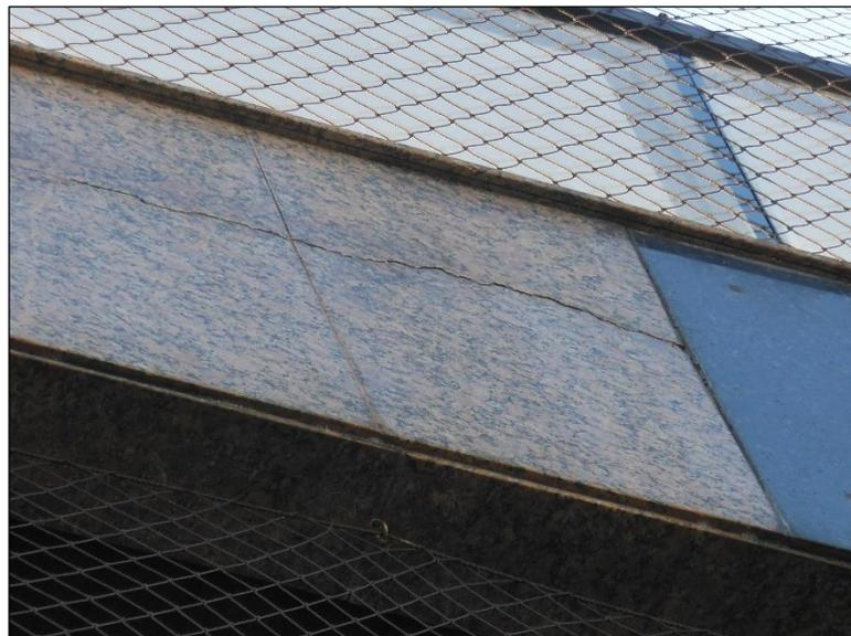
Figura 21: Trinca em placas de granito de fachada
