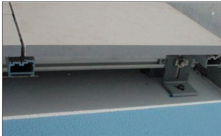
Figura 13: Detalhe de sistema de suporte com fixação de elementos verticais e horizontais
