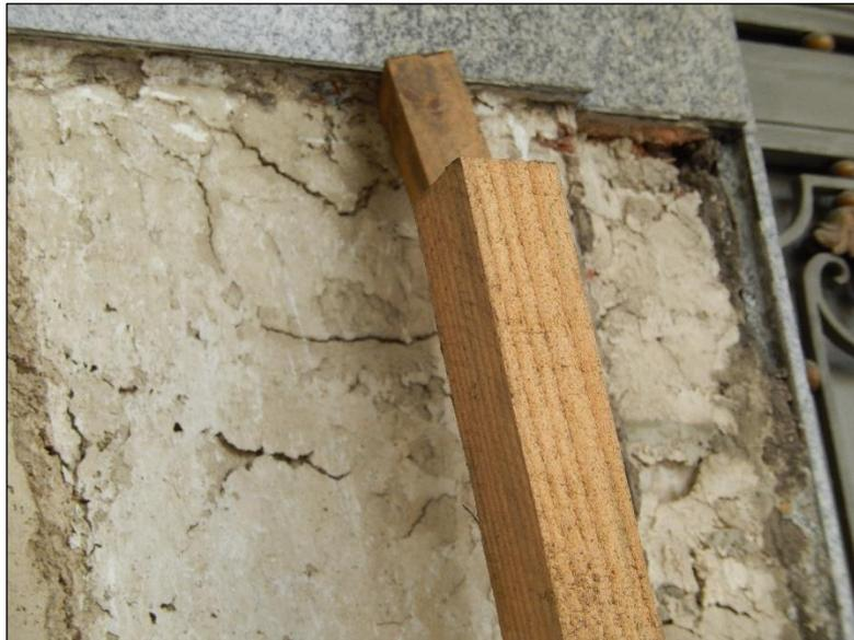
Figura 18: Detalhe de placa pétrea (granito) escorada.
