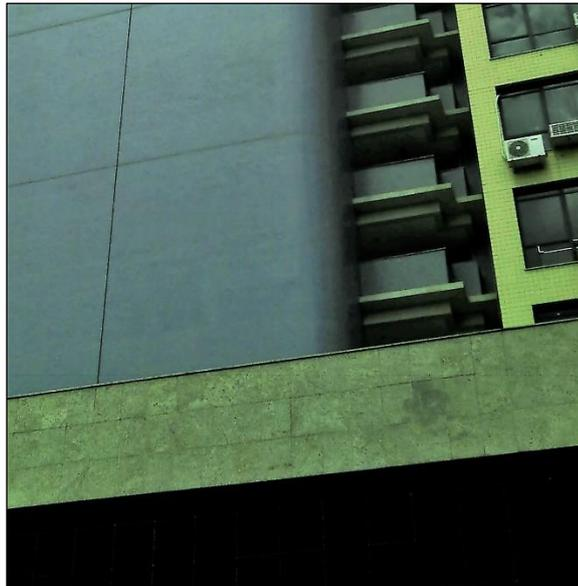
Figura 22: Placas de granito com manchas
