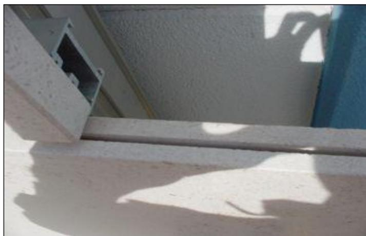
Figura 14: Detalhe de calha na pedra para colocação do clip de suporte
