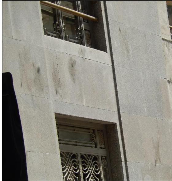
Figura 23: Placas de granito com manchas
