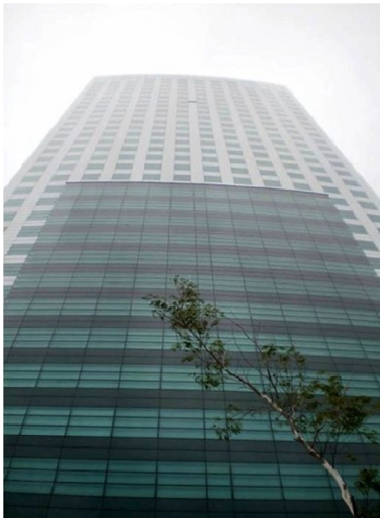
Figura 20: Fachada do edifício Eldorado Business Tower, São Paulo
