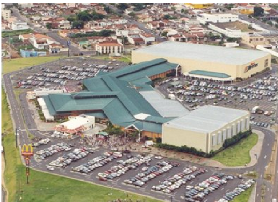
Figura 22: Vista aérea do Shopping Center Uberaba
