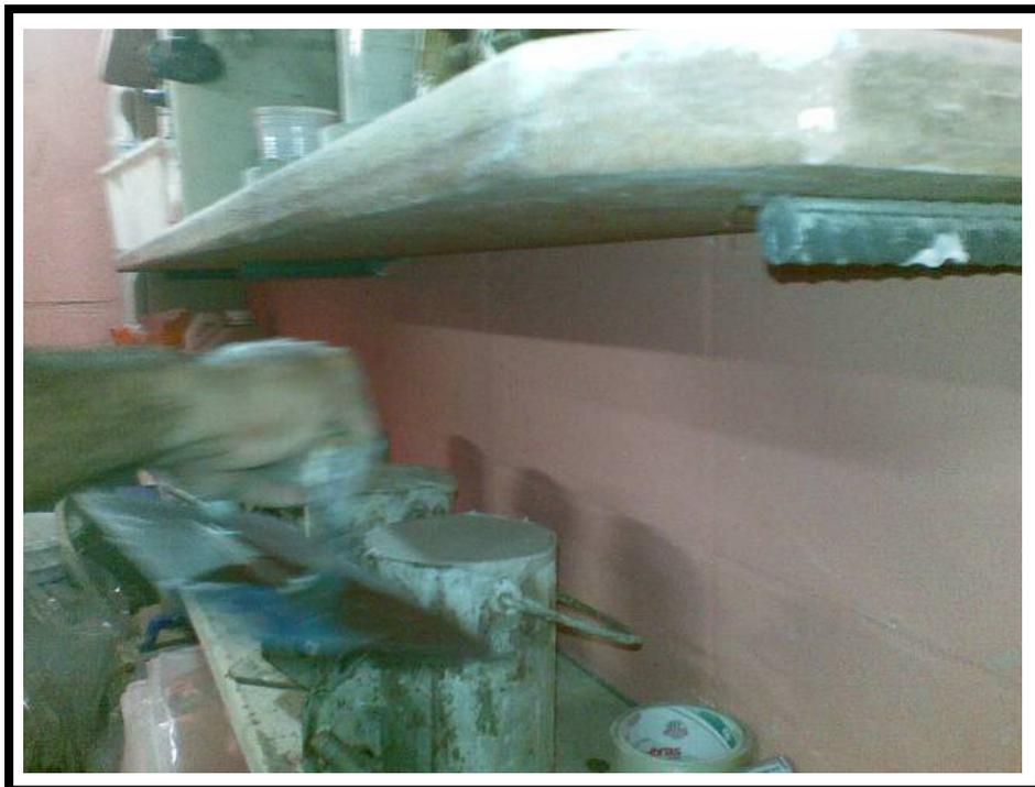
Figura 4.19: Acabamento com desempenadeira metálica.
