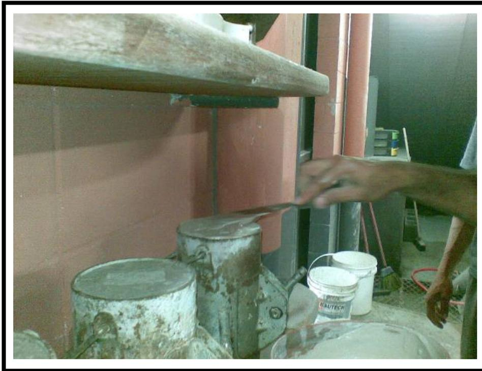
Figura 4.18: Preenchimento com argamassa polimérica rápida, Rapdez
