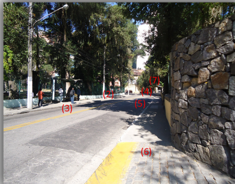
ACESSO AOS BLOCOS DO PRÉDIO DA ENGENHARIA: ENTRADA DE VEÍCULOS E PRINCIPAL ACESSO DE PEDESTRES AOS DEMAIS BLOCOS; SITUAÇÃO DE CONFLITO ENTRE PEDESTRES E VEÍCULOS. RAMPAS POSICIONADAS NO LOCAL DE ACESSO AO ESTACIONAMENTO. PISO TREPIDANTE.
