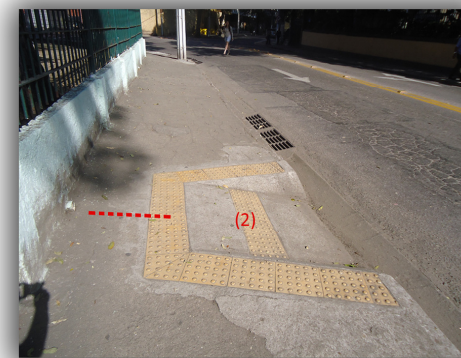
A ÁREA PARA MANOBRA ESTÁ FORA DO PADRÃO, A SINALIZAÇÃO PODOTÁTIL UTILIZA O PISO ALERTA, O QUE É ADEQUADO, MAS FORA DO PADRÃO NORMATIVO.
